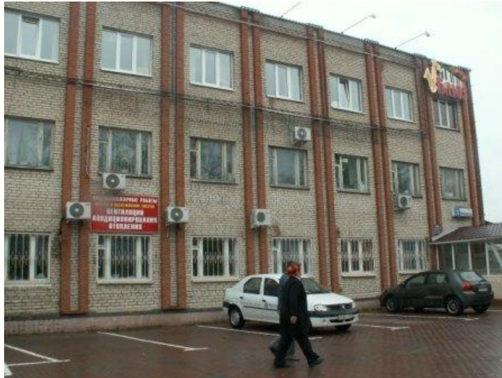
Фото. 1. Вид объекта под размещение БС
