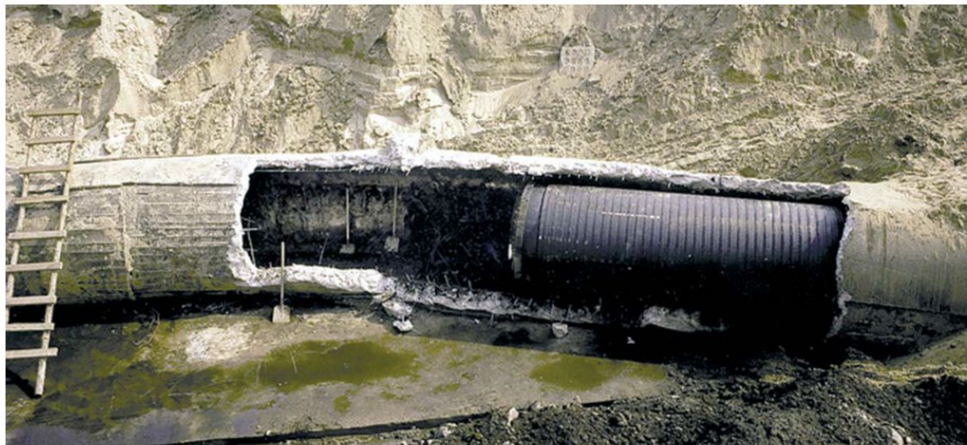
Ремонт бетонной трубы (внутренний d=1800 мм) с помощью полиэтиленовой трубы СПИРО (внутренний d=1500 мм).
