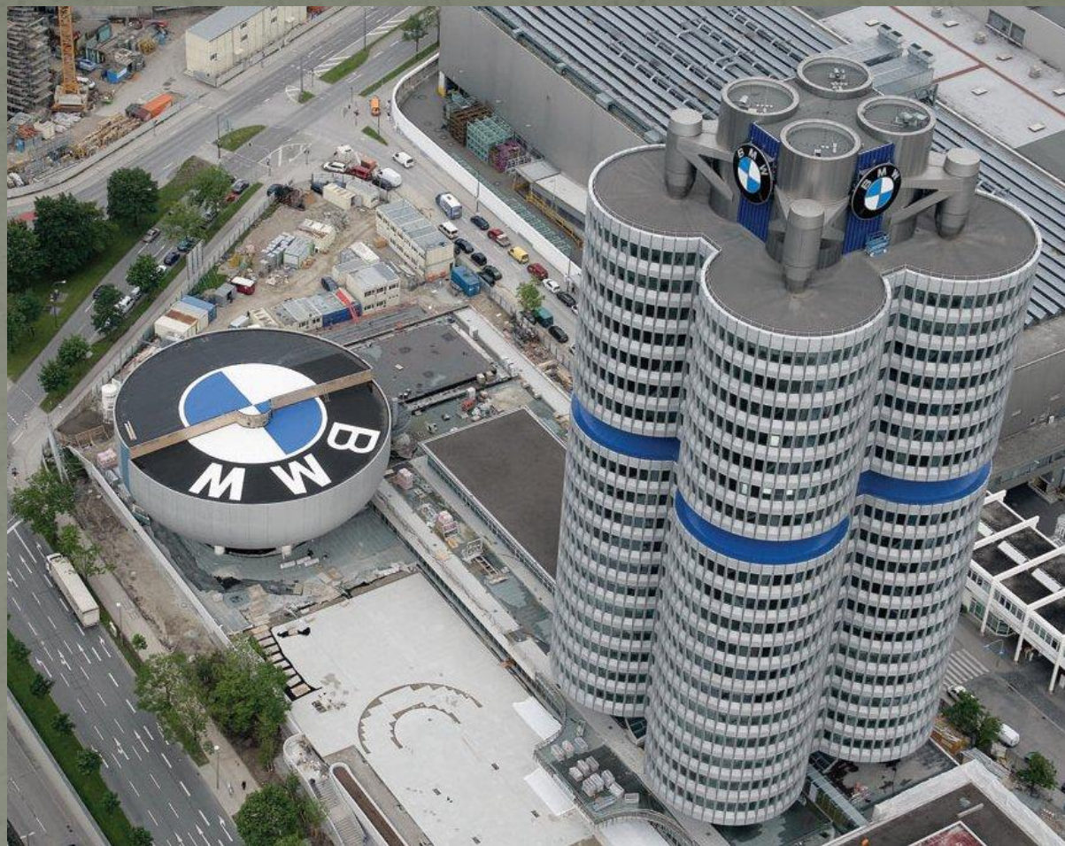
Штаб-квартира BMW и здание музея BMW в Мюнхене, Германия.
