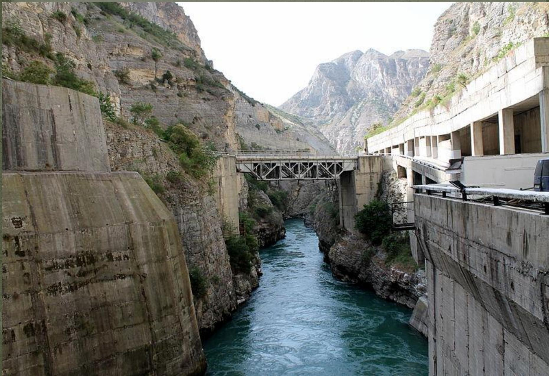
*Отводящий канал и камнезащитная галерея*
