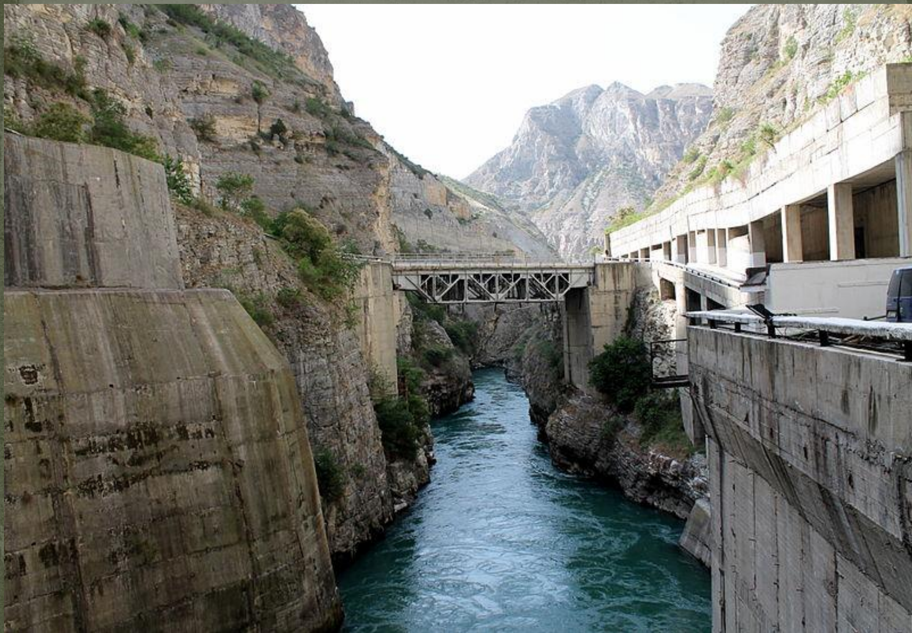
Отводящий канал и камнезащитная галерея
