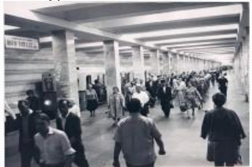
Станция Проспект Вернадского г.Москва
