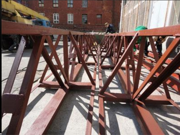
Подготовка элементов фермы к сборке
