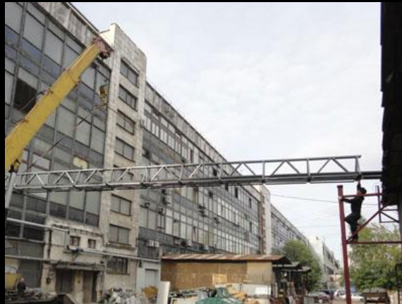
Установка фермы в проектное положение
