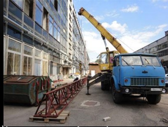
Укрупнительная сборка фермы
