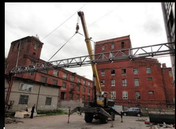
Монтаж фермы автокраном
