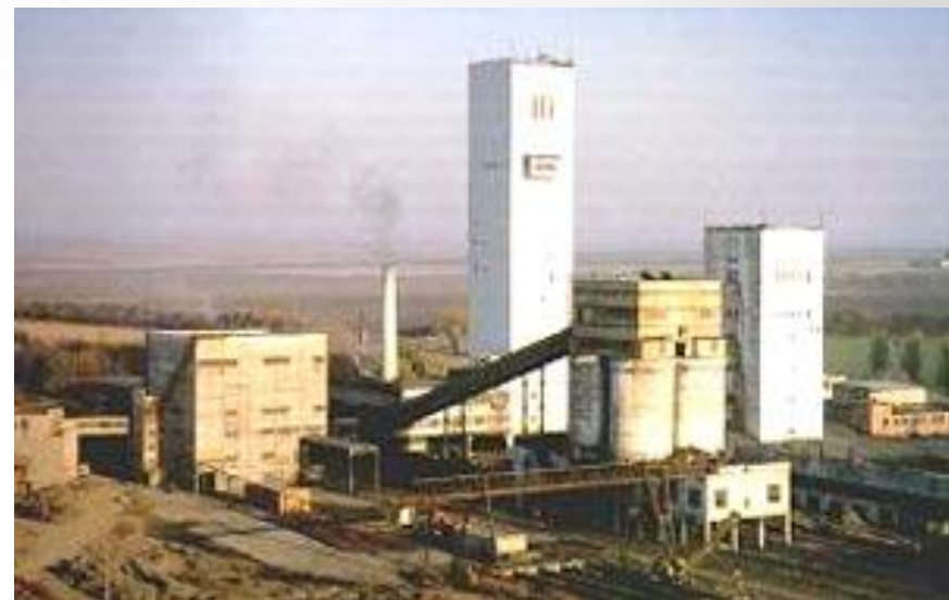
Надшахтный комплекс шахты «Южнодонецкая 1»
