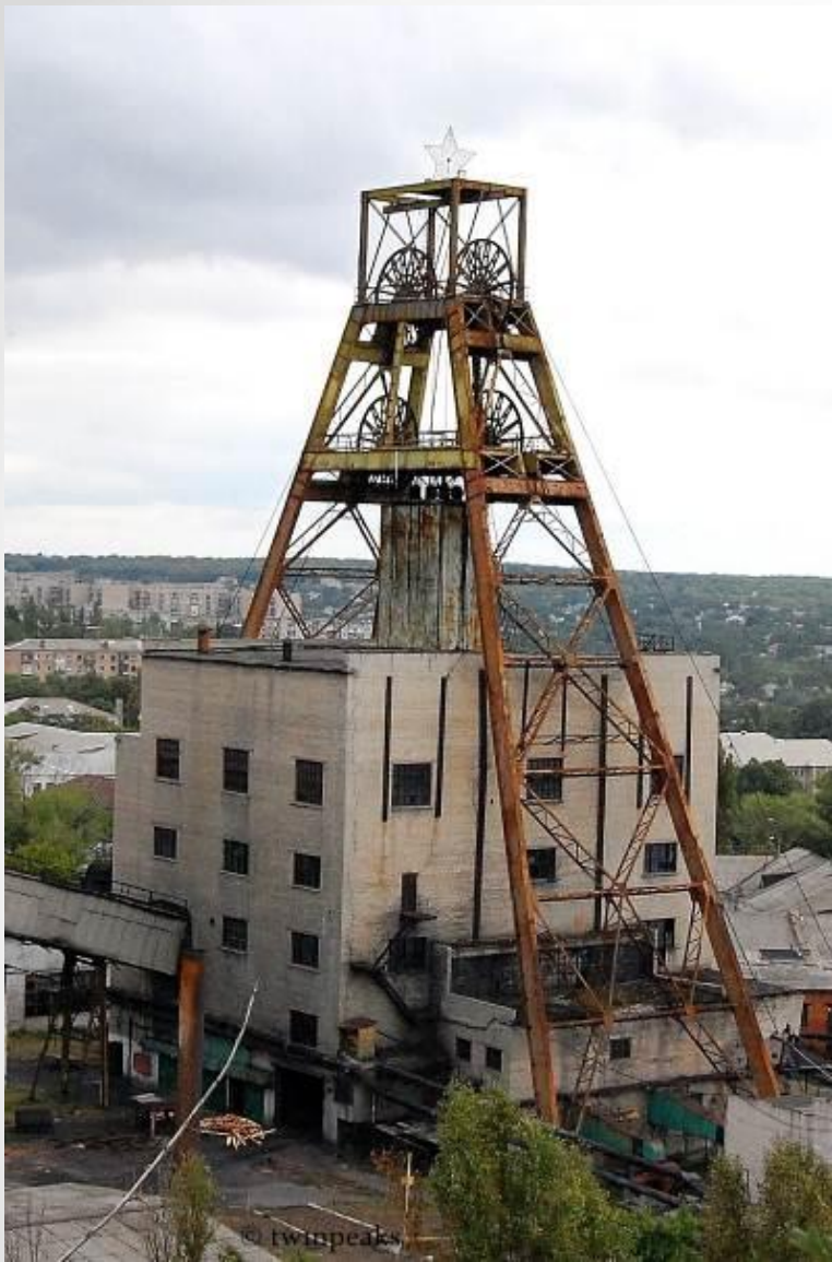
Надшахтное здание шахты «Ударник»
