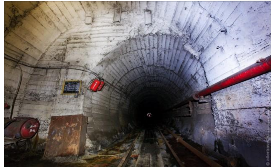
Бетонирование штрека
