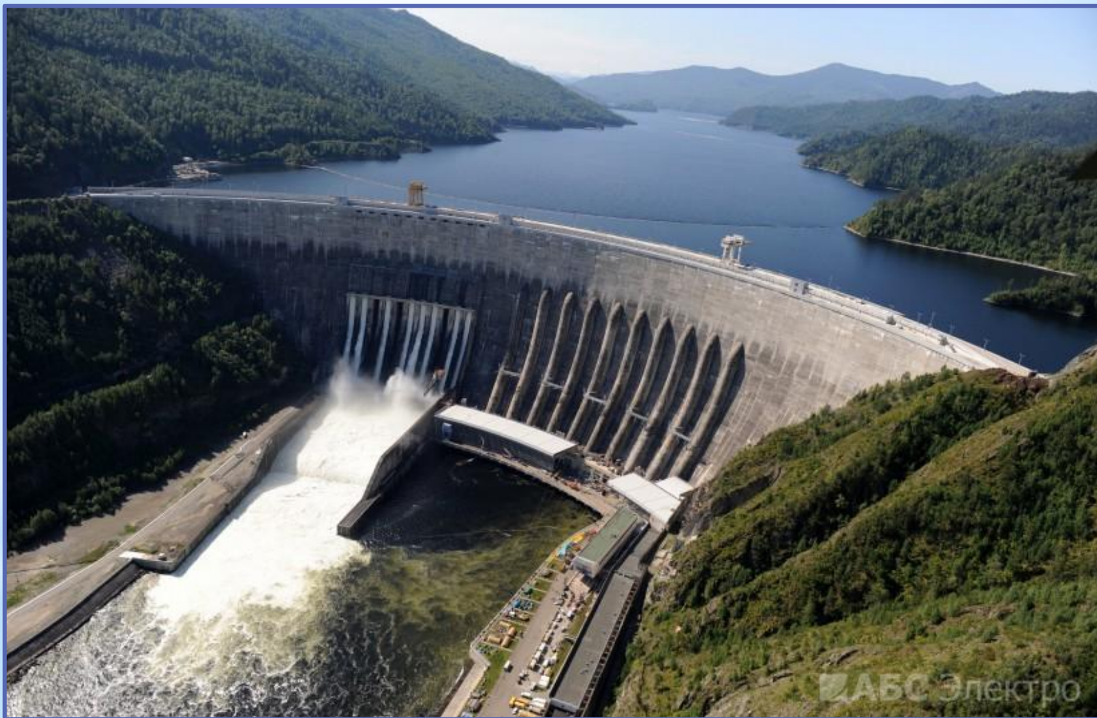
«Саяно-Шушенская ГЭС», респ. Хакасия (6400 МВт)
