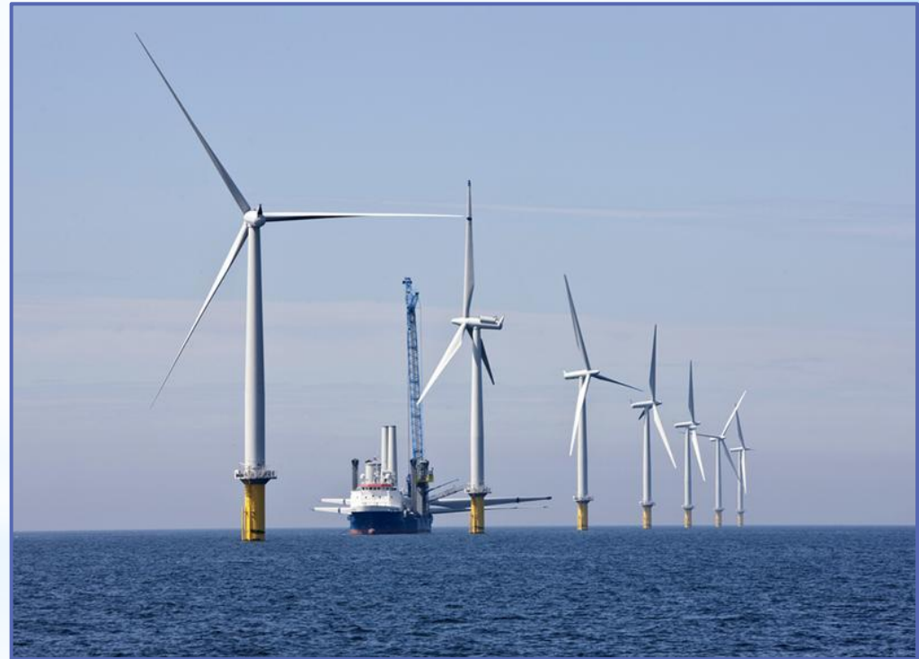
Ветряная электростанция Siemens
