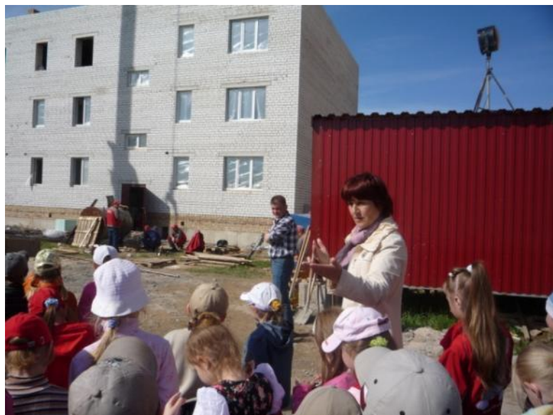
Экскурсия на стройку
