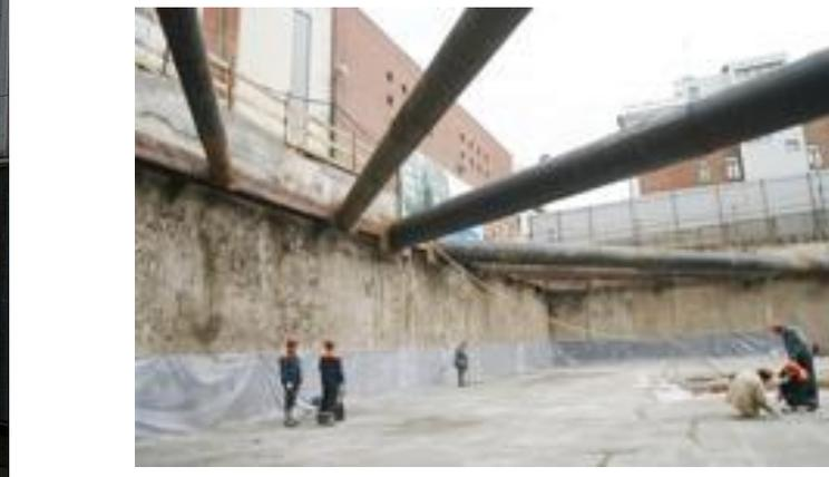
Полученная стена в грунте замыкается в плане и создается единая конструкция. Грунт постепенно выбирается в направлении сверху – вниз, с устройством дисков перекрытий – элементов жесткости, играющих роль распорок.
