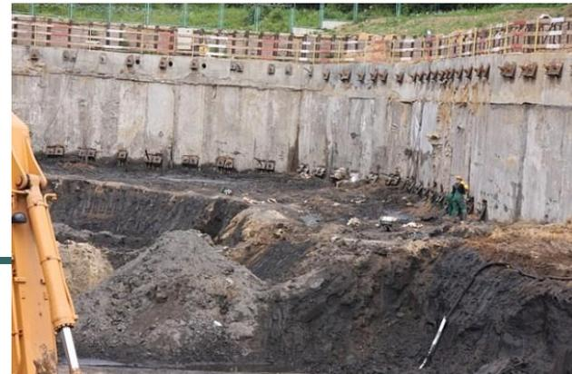
В основном предназначается для заглубленных сооружений. По контуру здания вырывается узкая и глубокая траншея, заполняющаяся готовыми элементами из железобетона или просто бетоном. Рационально применяется для строительства тяжелых зданий, подземных сооружений (гаражей, подземных этажей домов, переходов).
