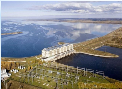
Рыбинская ГЭС, р. Волга (13 м)
