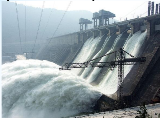
Красноярская ГЭС, р. Енисей (93 м)
