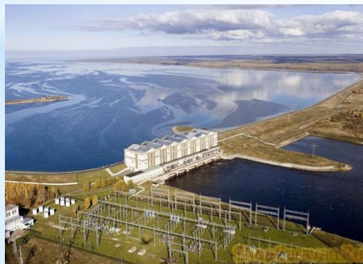
Рыбинская ГЭС, р. Волга (13 м)
