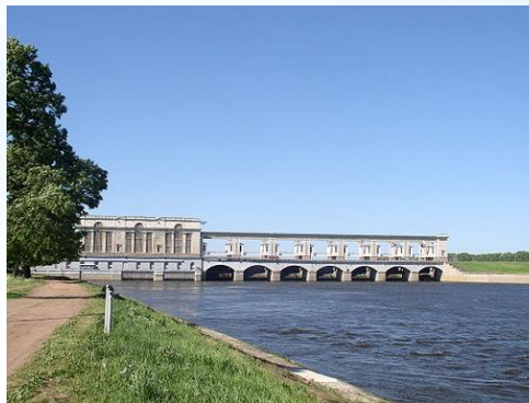
Угличская ГЭС, р. Волга (13,6 м)
