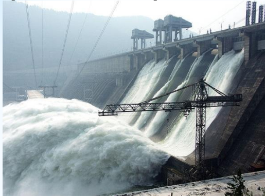
Красноярская ГЭС, р. Енисей (93 м)
