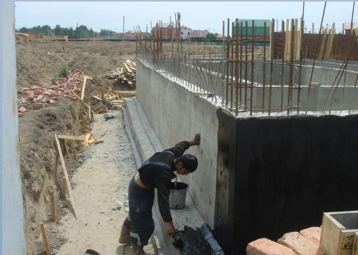
Этот вид защиты наносится на поверхность фундамента и подбирается в зависимости от физической структуры грунта, в котором он закладывается. [3]
