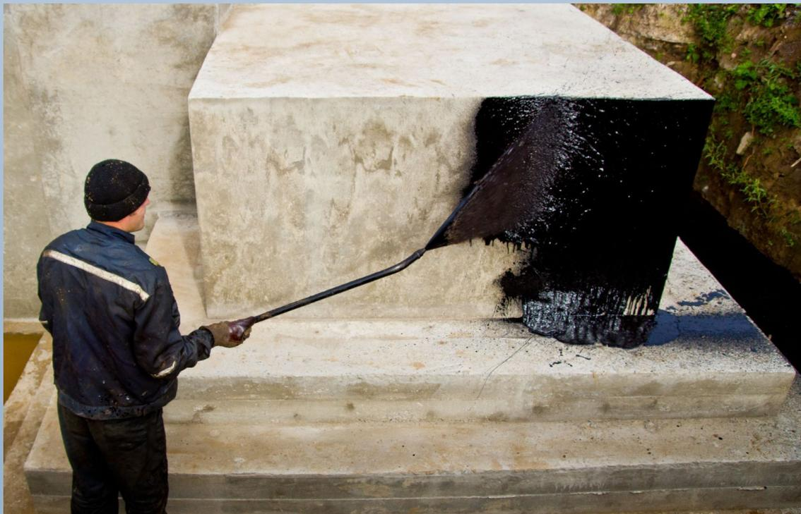
В качестве легкой изоляции с успехом используются битумные растворы и эмульсии, битумно-полимерные (например, Славянка и Bitumast) и асфальтовые мастики, которые легко наносятся на подготовленную поверхность фундамента. Битумная смола является самым дешевым материалом для обмазочной гидроизоляции, которая послужит около 5 лет. Срок службы обмазочной гидроизоляции значительно увеличивает использование битумно-полимерных мастик, наносимых горячим и холодным способом.[3]
