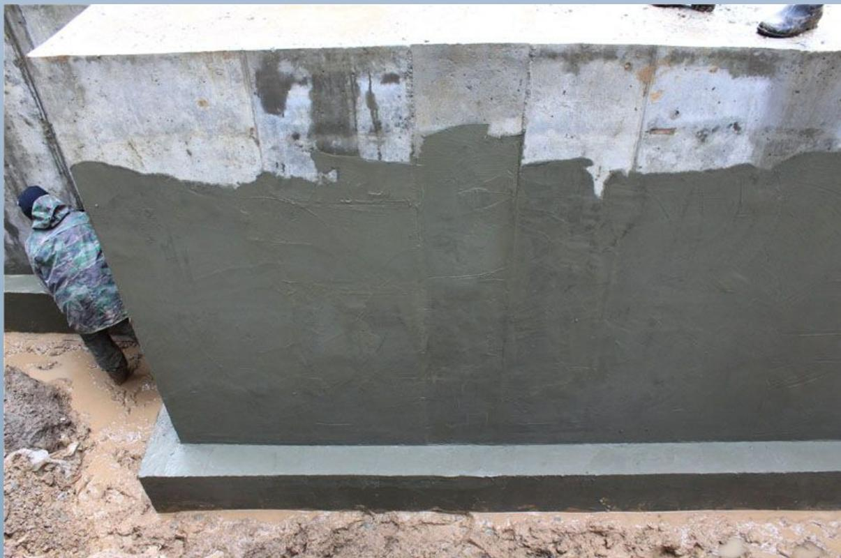
Эти гидроизоляционные покрытия, изготавливаемые из битумно-полимерцементных смесей, можно применять в условиях невысокой водной нагрузки.[7]
