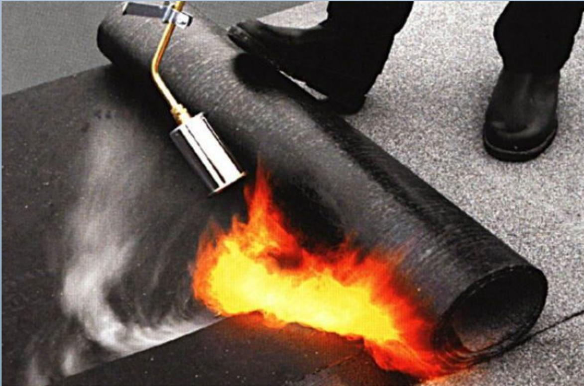
Этот вид антифильтрационной и противокапиллярной защиты эффективен для сооружений, имеющих подвал или цокольный этаж и расположенных на участках, где уровень грунтовых вод значителен. Для него используют рулонные материалы (гидроизол, рубероид, бризол и пр.), наклеивая их на поверхности с помощью мастик или способом наплавления (разогревая газовой горелкой).[6]
