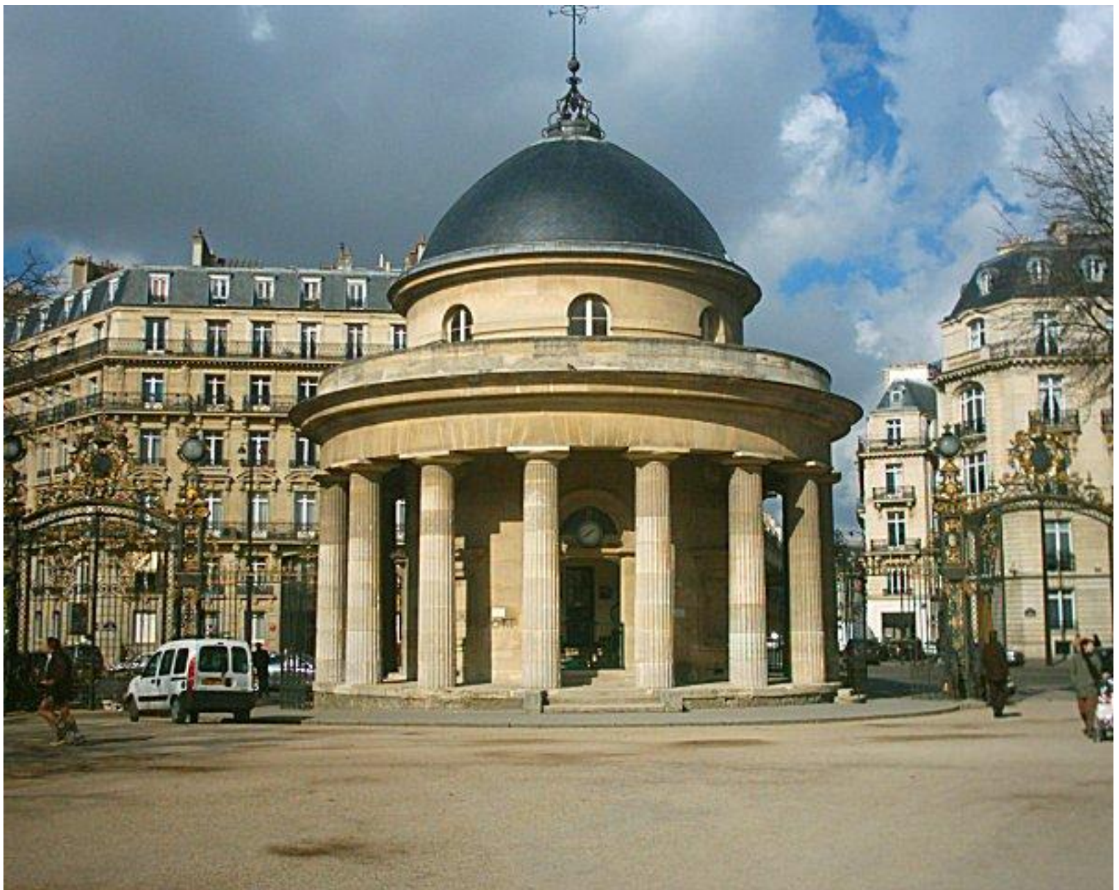
Barrière de Chartres, rotonde du parc Monceau
