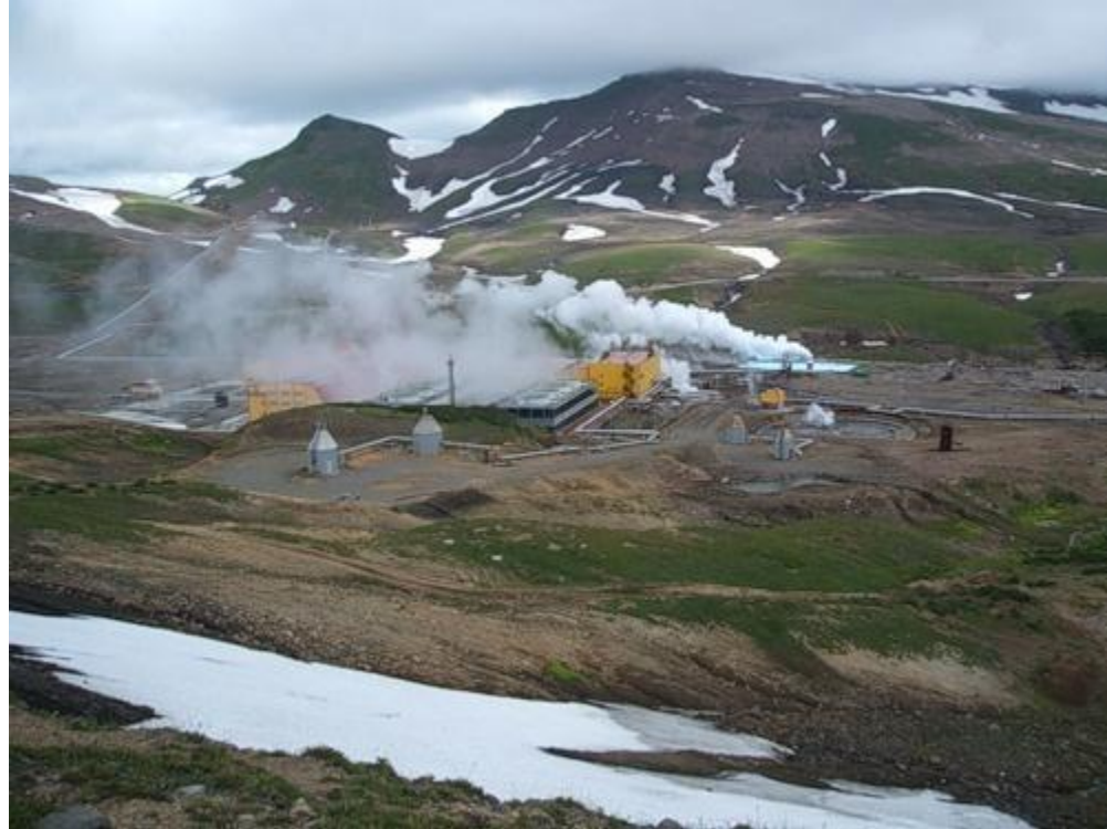
Мутновская геотермальная станция
