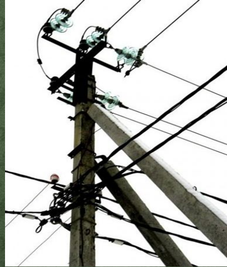
Воздушная линия электропередачи 10 кВ
