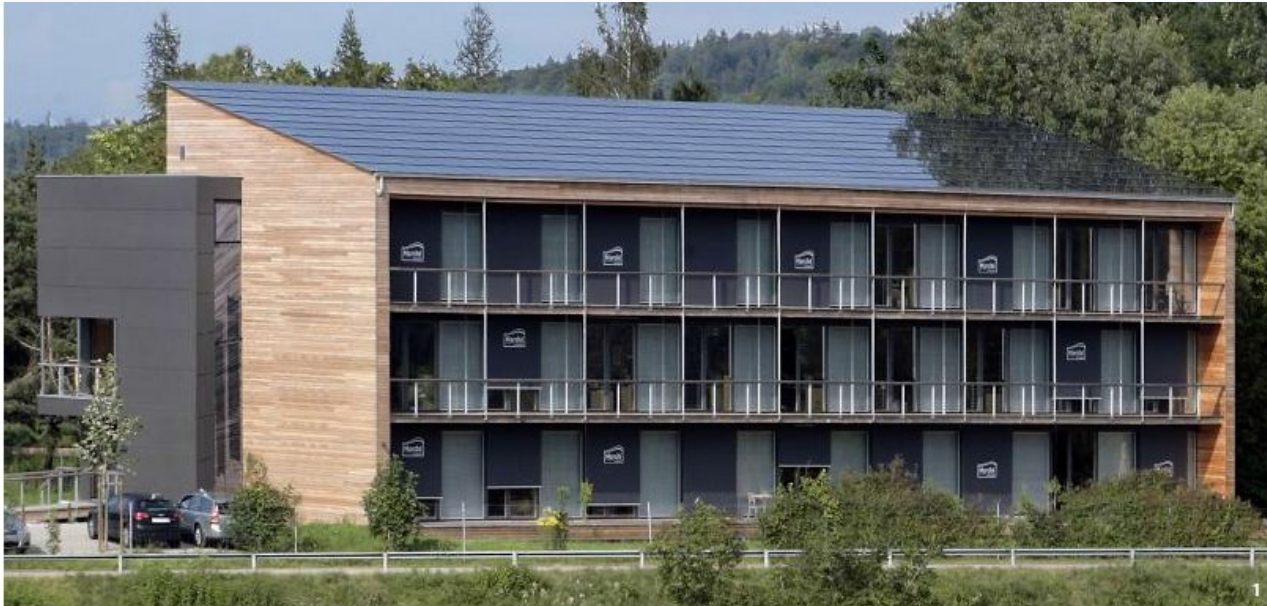
Офисное здание «Marce International Support Office». Beat Kampfen Office for Architecture
