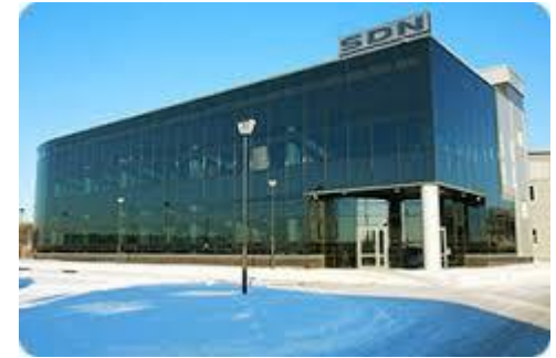
Санкт-Петербург. Stack Data Network
