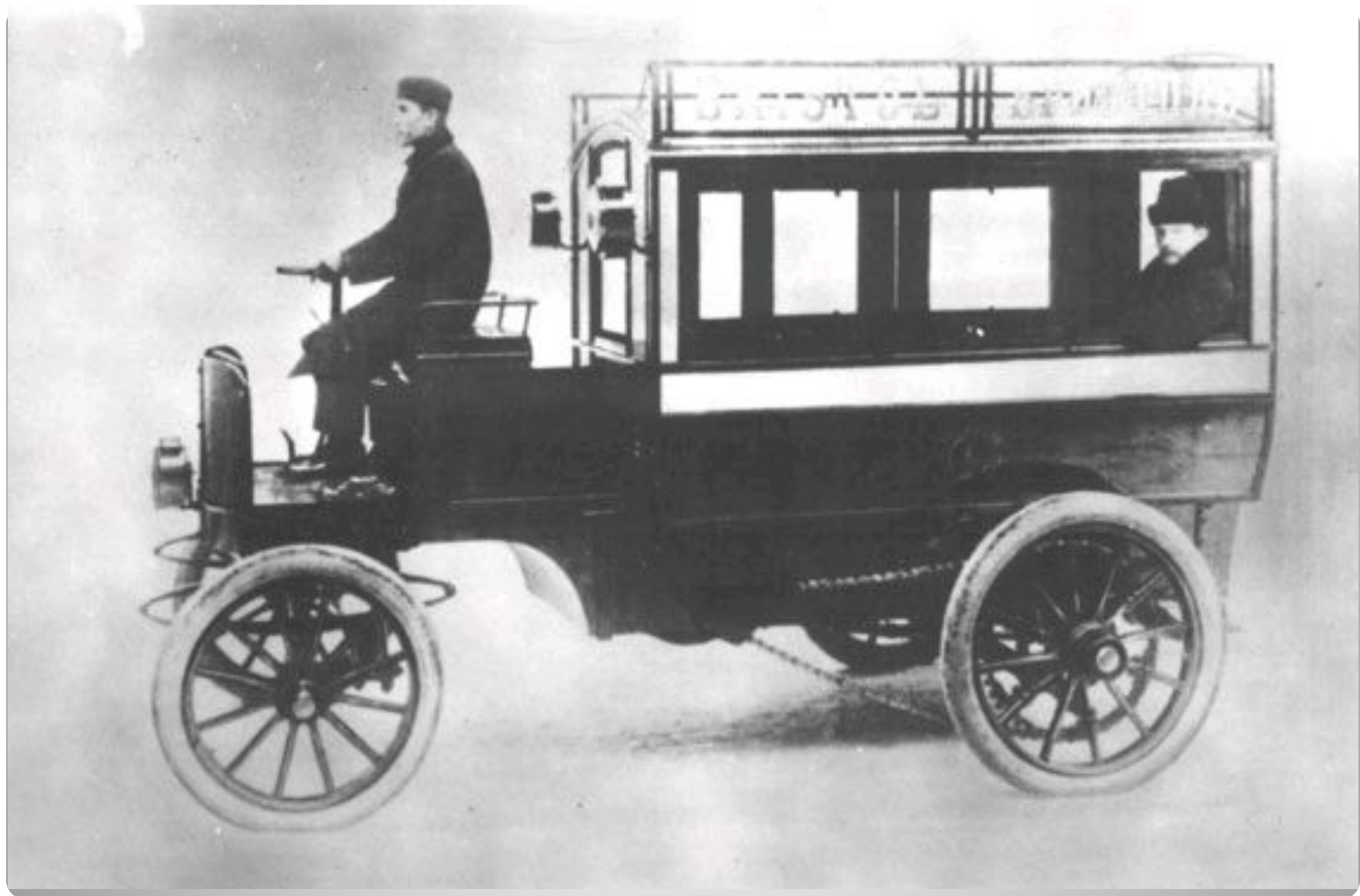
Электрический омнибус завода "Дукс", 1902 г.
