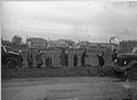
Подготовка к работам
