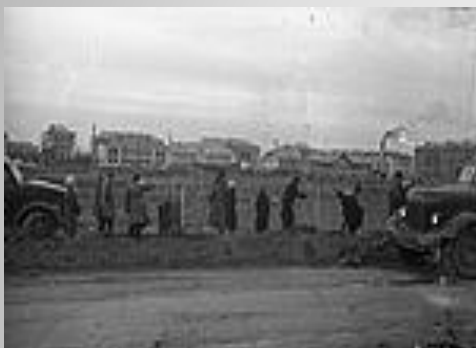
Подготовка к работам
