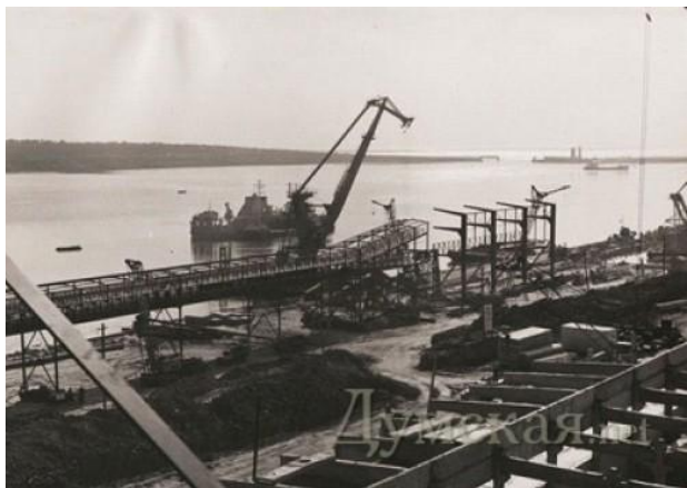
Строительство Одесского припортового завода
