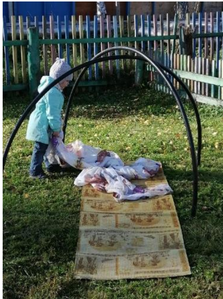
Маша, утеплив пол, принимается за постройку крыши. (Полянка).
