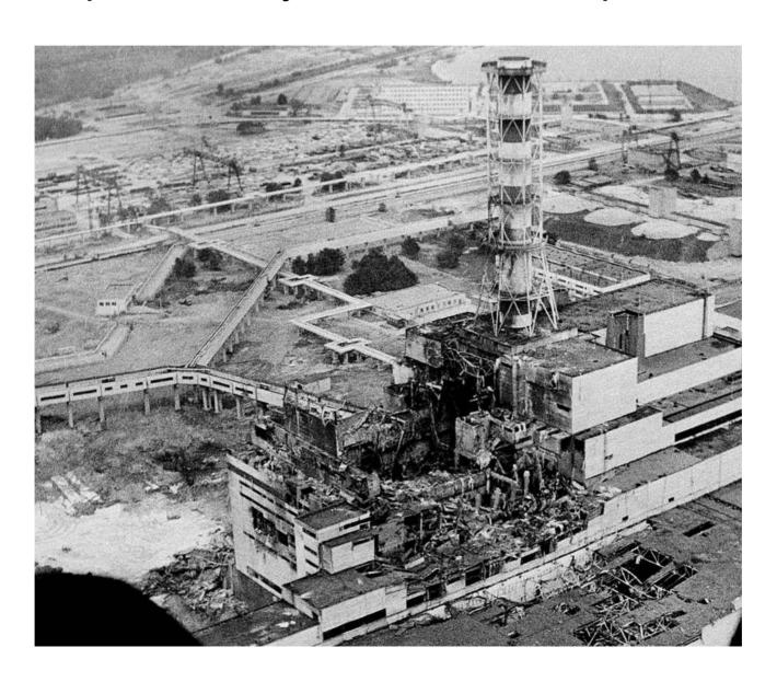
Из реактора были выброшены раскаленные куски ядерного топлива и графита. Столб горящих материалов и газов взлетел на высоту более одного километра. Активная зона реактора была полностью разрушена. В атмосферу была выброшена колоссальная радиоактивность. Мощность дозы радиационного поля внутри и около 4-го энергоблока измерялась тысячами и десятками тысяч рентген в час. Изуродованные взрывной волной помещения охватил пожар.
