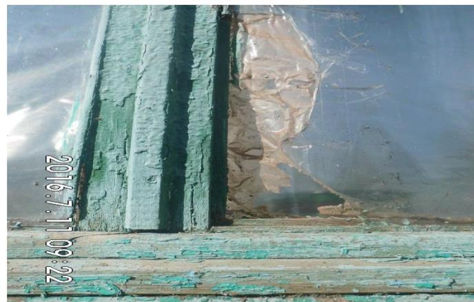
Крыша протекает. Под тяжестью дождевых вод, потолок над самой входной дверью прогибается. После сильных дождей на полу образовывается лужа.
