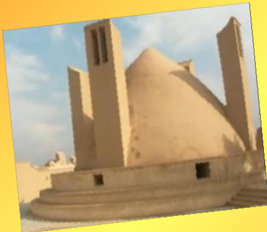
Впервые попытались профессионально кондиционировать жаркий воздух в Персии около 1000 лет назад. Процесс охлаждения воздуха происходил по принципу охлаждения воды в помещении при испарении. Подобием кондиционера тех дней являлась специальная шахта, которая улавливала потоки ветра. Внутри шахты нужно было поместить емкости с водой или использовать непосредственно само течение воды из источников.
