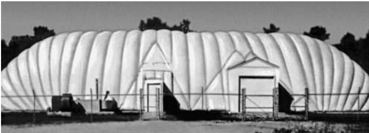
Пневматические сооружения. Воздухоопорное с усиливающими канатами (тросами).
