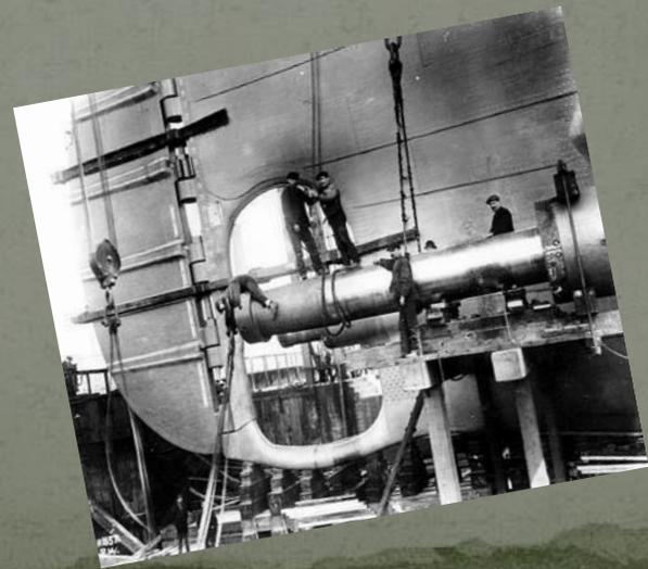
Основными критериями при проектировании ходовой части кораблей были надежность, экономичность и достаточно плавный ход. "Титаник" был оснащен многоступенчатой паровой турбиной, которая вращала центральный (рулевой) винт и двумя четырехцилиндровыми поршневыми двигателями, которые передавали движение боковым винтам.
