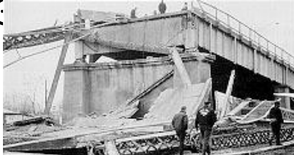
Обрушение Серебряного моста.
