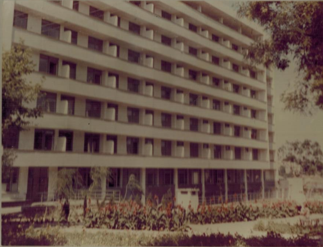
СЕМИЭТАЖНЫЙ ХИРУРГИЧЕСКИЙ КОРПУС НА 270 КОЕК ВВЕДЕН В СТРОЙ В 1978 ГОДУ
