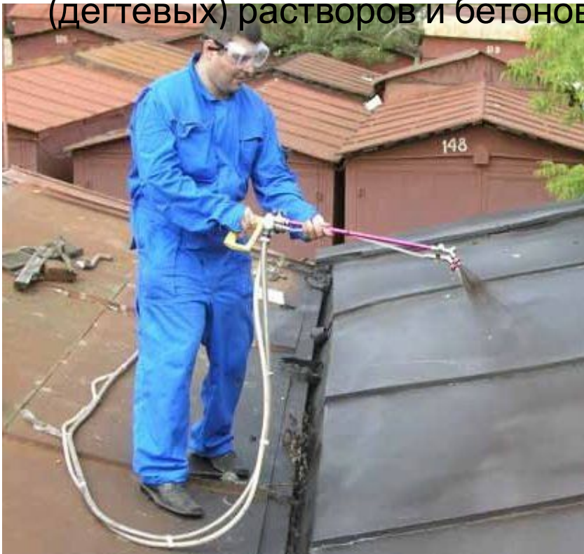
Рисунок 14.3 – Бесшовная гидроизоляция на основе битумной эмульсии
