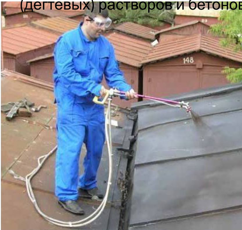
Рисунок 14.3 – Бесшовная гидроизоляция на основе битумной эмульсии
