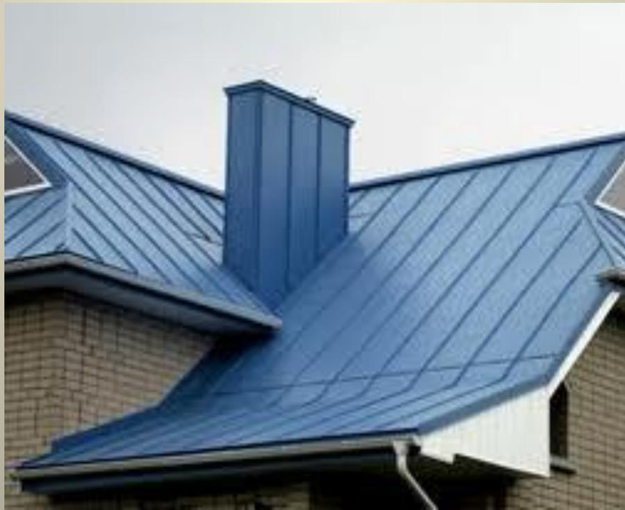
Металлические листы эстетичны и имеют небольшую хрупкость, поэтому удобны для устройства кровли различных типов, профилей и с разным уклоном .
