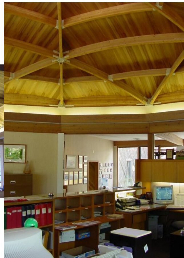
Купол из полурам бумеранг, разгруженный подвесным диском
