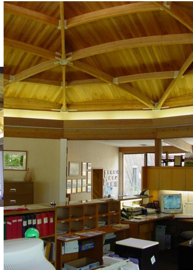
Купол из полурам бумеранг, разгруженный подвесным диском
