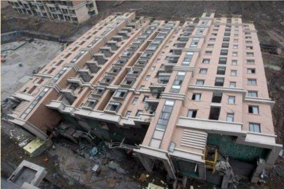
13-этажный дом был монолитно-каркасным, поэтому упал без разрушений, ровно на бок. Официальная версия падения здания – строительство подземного гаража в условиях рыхлого грунта. Существует мнение, что при постройке этого дома просто были нарушены технологии строительства. Население Шанхая составляет 24 миллиона человек, в городе остро стоит проблема нехватки жилья. Поэтому большинство строительных компаний старается сдавать объекты в сжатые сроки
