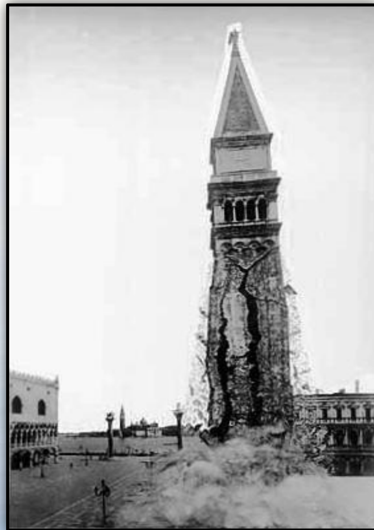
Падение колокольни собора св. Марка в Венеции, вызванное разрушением грунтов основания
