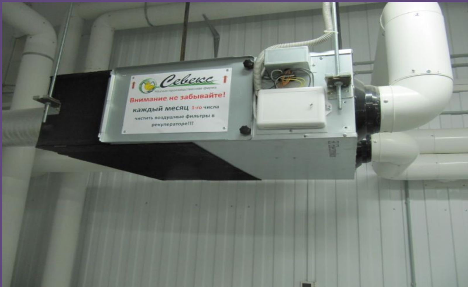
Автоматический рекуператор воздуха со встроенными фильтрами
