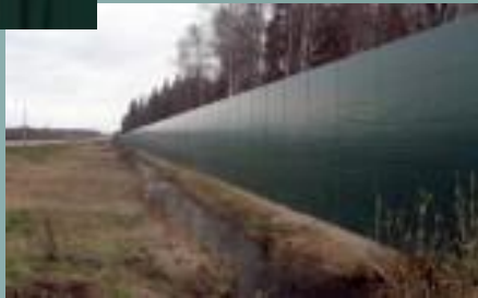
← Строительство шумоотражающего забора из профнастила, с козырьком.
