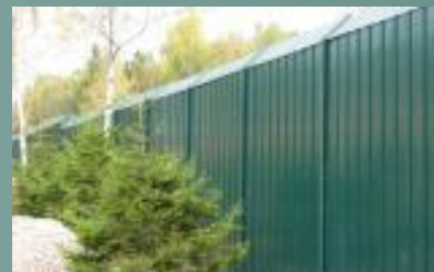
↗ Двухслойный шумоотражающий забор из профилированного листа с козырьком (внутренняя сторона).
