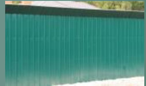
↑ Двухслойный шумоотражающий забор из профилированного листа с козырьком .
