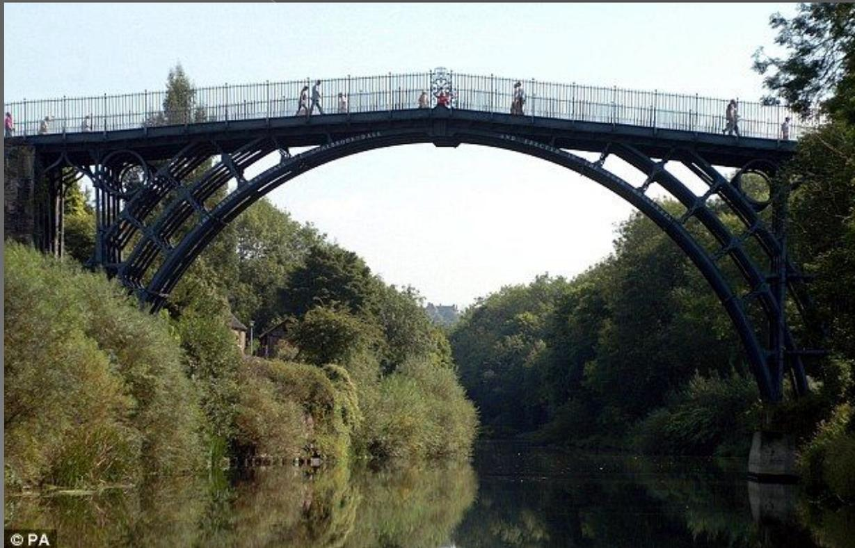
Железный мост (Iron bridge) пересекает реку Северн в Шропшире. Это первый арочный мост в мире, который изготовлен из чугуна. Для строительства моста понадобилось 379 тонн металла.
