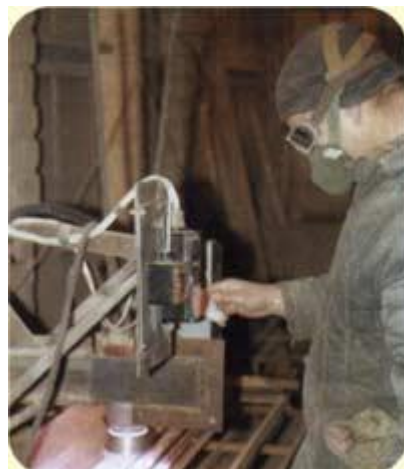
Нанесение латунного ЭМП на бойлерные трубки
