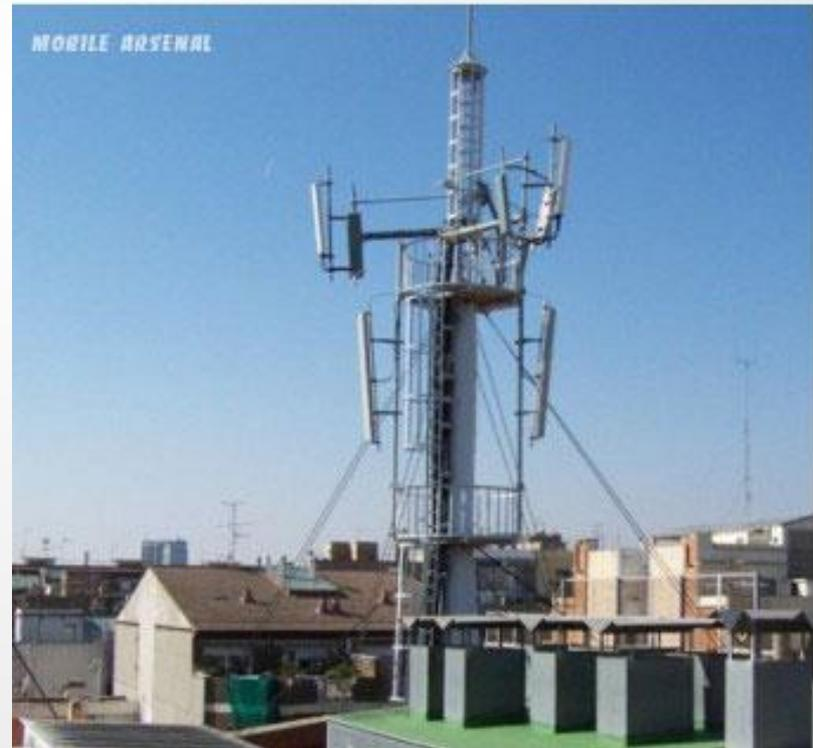
**Сотовая связь — один из видов мобильной радиосвязи, в основе которого лежит сотовая сеть. Ключевая особенность заключается в том, что общая зона покрытия делится на ячейки (соты), определяющиеся зонами покрытия отдельных базовых станций. Соты частично перекрываются и вместе образуют сеть. На идеальной поверхности зона покрытия одной базовой станции представляет собой круг, поэтому составленная из них сеть имеет вид сот с шестиугольными ячейками (сотами).**
