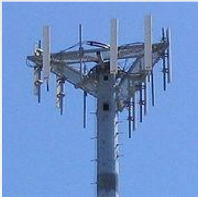
**Сеть составляют разнесённые в пространстве приёмопередатчики, работающие в одном и том же частотном диапазоне, и коммутирующее оборудование, позволяющее определять текущее местоположение подвижных абонентов и обеспечивать непрерывность связи при перемещении абонента из зоны действия одного приёмопередатчика в зону действия другого.**
