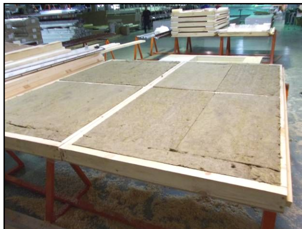
Каркас с утеплителем
