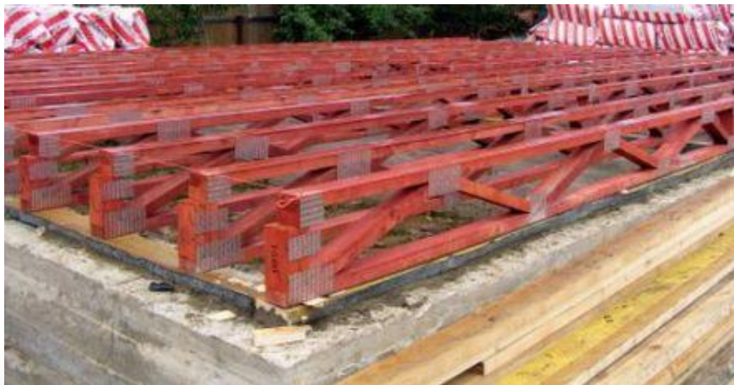
Устройство основания под каркасно-щитовой дом
