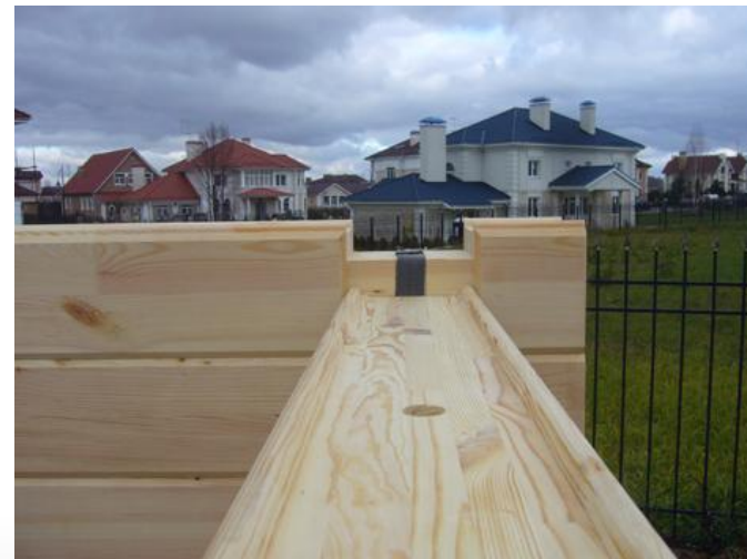
Применение предварительно сжатой уплотнительной ленты
