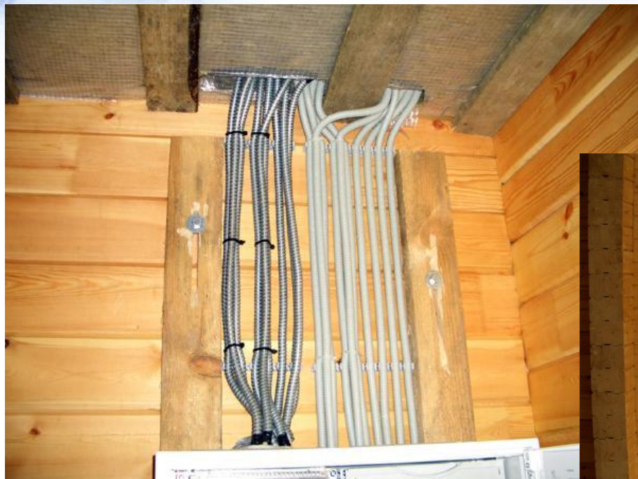
Скрытая электропроводка
