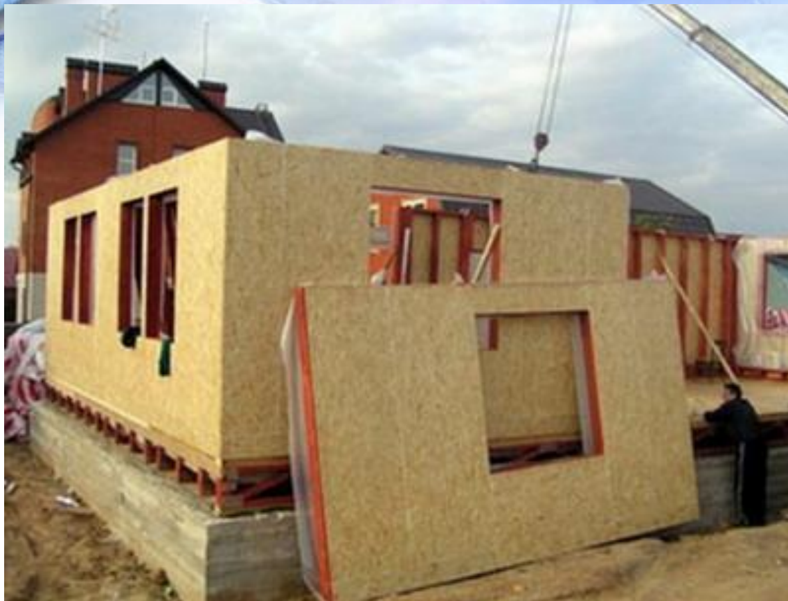
Возведение стен каркасно-щитового дома
