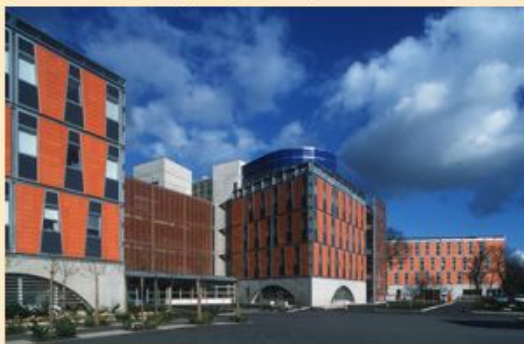
Офисы Транспас, Ренн, архитектор Фикепаль д.Арюсмон
