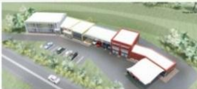
Газобетонные блоки на металлическом каркасе
