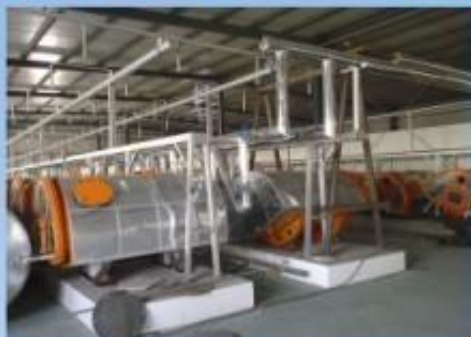
单晶机安装现场
