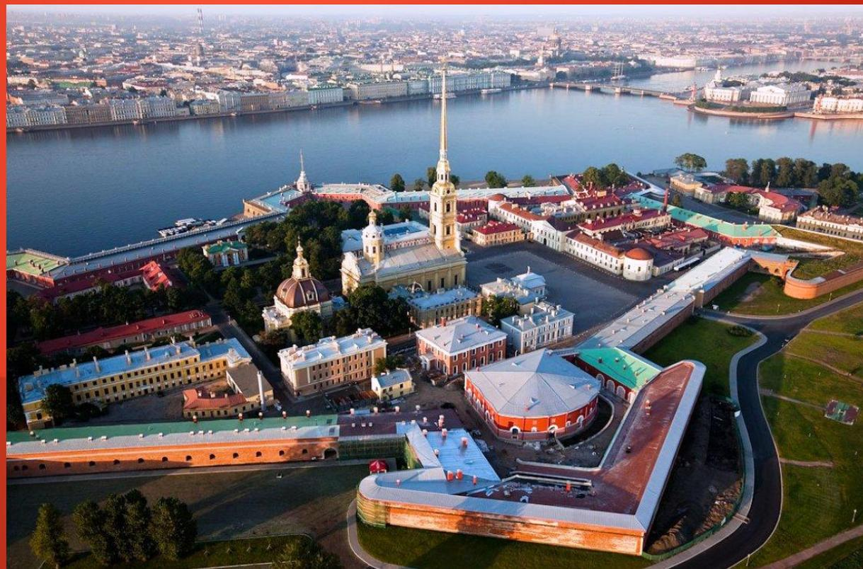
План крепости разрабатывал лично император Пётр 1. Он сделал ее в форме неправильного шестиугольника с выступающими угловыми укреплениями-бастионами, которые между собой соединены стенами-куртинами. Первоначально крепость была деревянной, но уже в 1706 году под руководством архитектора Трезини началась замена старых сооружений на новые — кирпичные.
