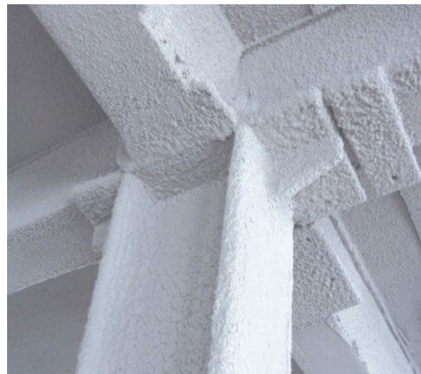
Покрытие негорящим раствором
