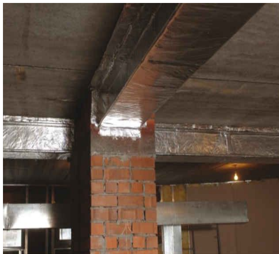
Обтяжка теплоизоляционным негорящим материалом
