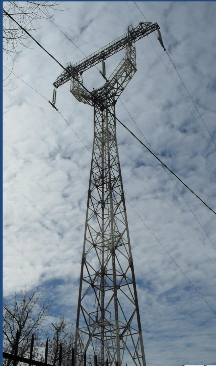
Переходная опора ВЛ 220кВ (Химки)
