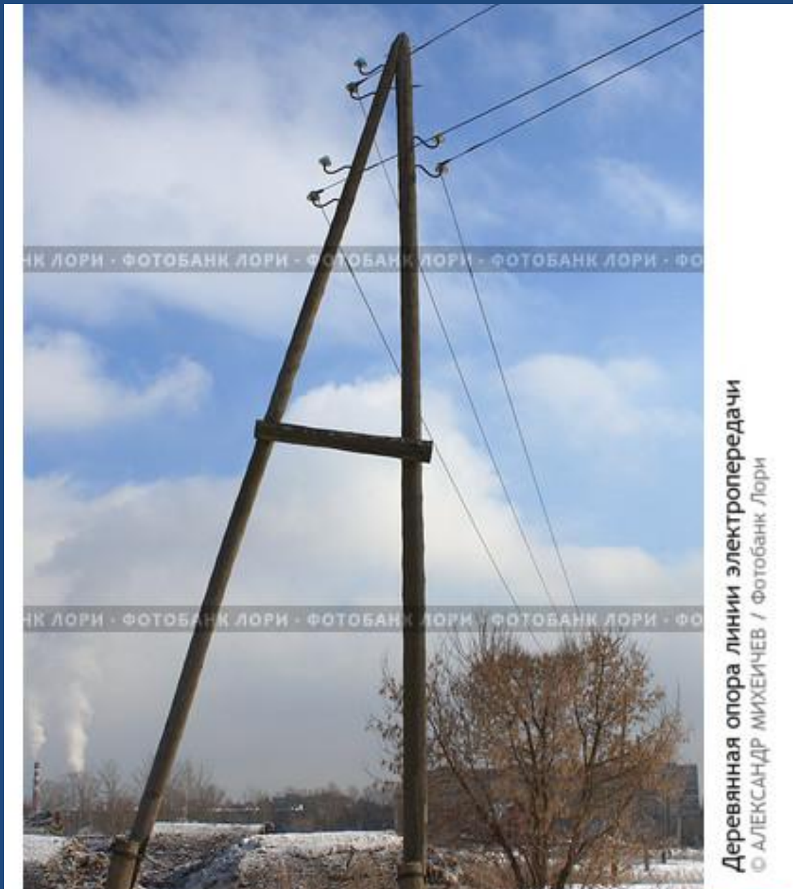
Деревянная анкерно-угловая опора ВЛ 10кВ на деревянных пасынках
