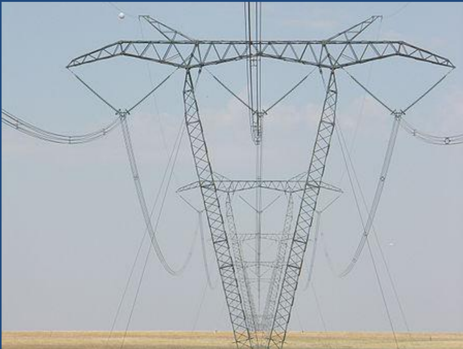
Качающиеся решетчатые металлические опоры ЛЭП СВН (Африка)
