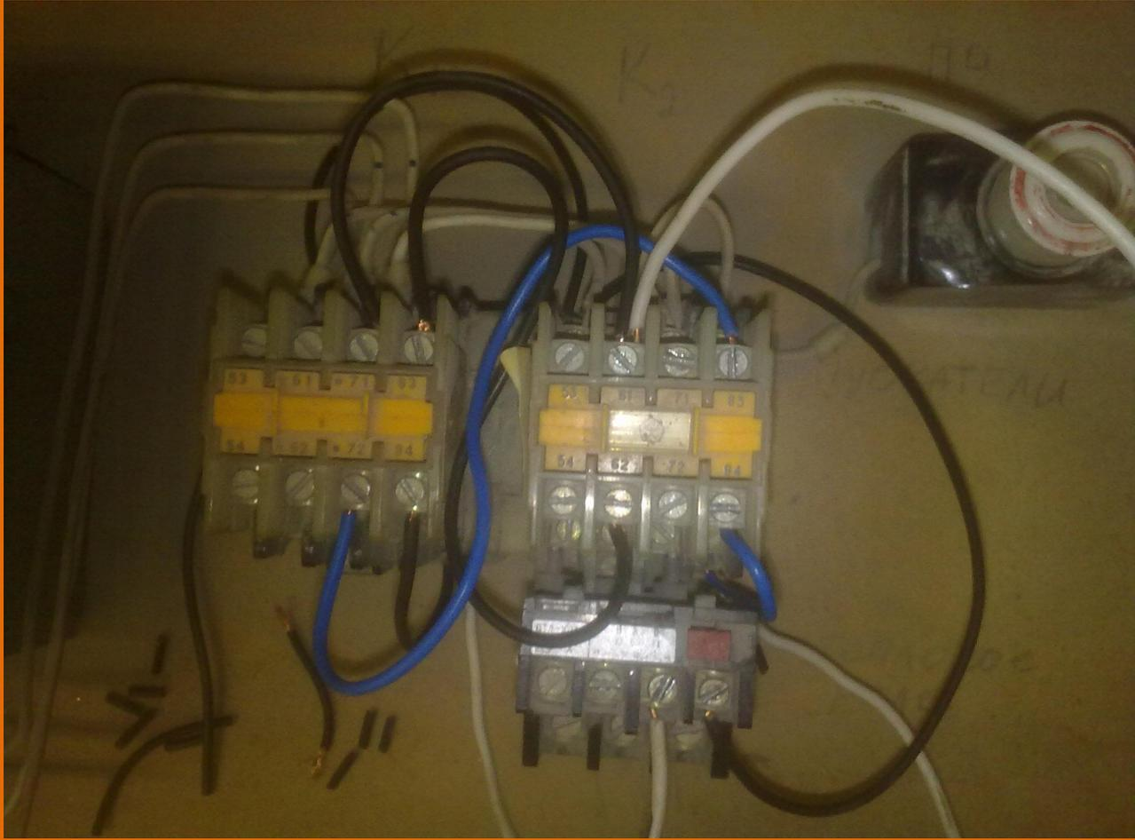
Процесс сборки схемы реверсивного пуска двигателя, на фотографии изображено подключение реверса к пускателям.
