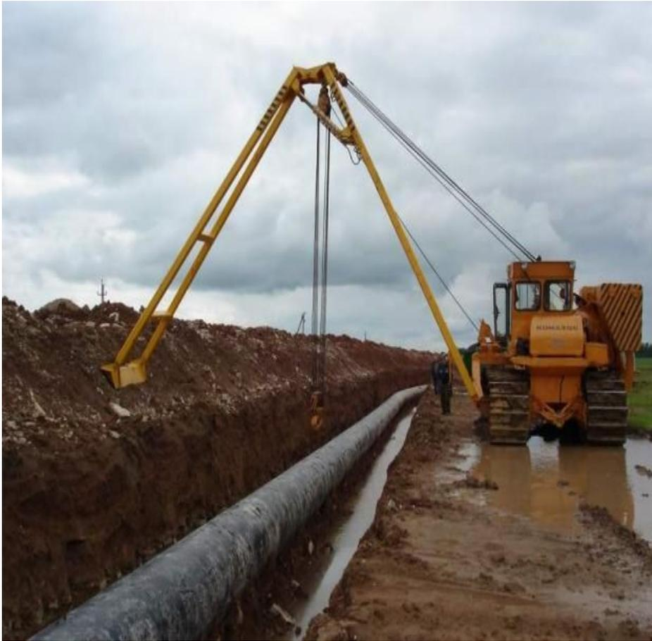
предназначен для удерживания и одновременно укладки трубопроводов в траншею, погрузочно-разгрузочных работах вне полосы магистральных газо-нефтепроводов, при прокладке канализационных и водопроводных сетей городских коммуникаций
