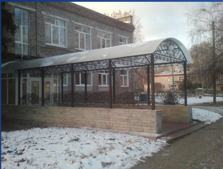
Внешний вид здания
