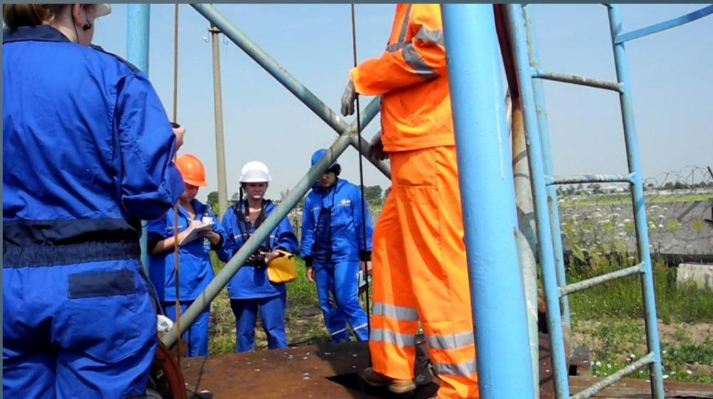
Перед началом работы проводится процедура, называемая «отбивка нуля». Кабель пропускается через блок-баланс, подаётся команда и станции, и машинисту. Головка прибора помещается на ноль скважины. Счётчики сбрасывают на ноль и дальнейшее движение начинается с расчёта глубины погружения
